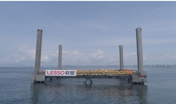
網箱安裝完成 Completion of Installing Cages
